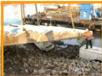
Die Treppe wird eingebaut
