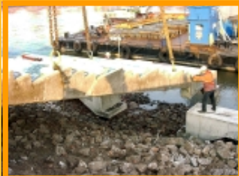
Die Treppe wird eingebaut
